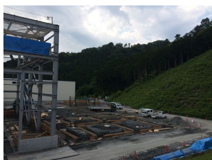
（建設中の木質バイオマス発電所）
