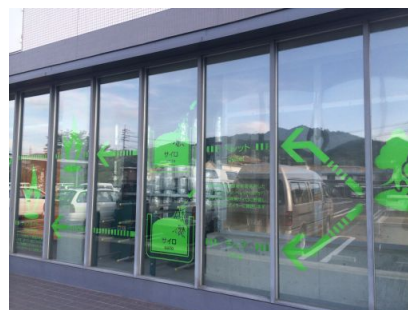
（エネルギー棟のガラス壁面）
